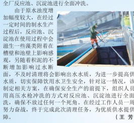
本报讯： 因近期温度变化，上游来水增多，为确保出厂水安全，10月份以来，凉亭山水厂组织生产人员对全厂反应池、沉淀池进行全厂冲洗。 由于原水浊度增加幅度较大，在经过一定时间的制水生产后，反应池、沉淀池在长期使用过程中会产生一些微生物附着在槽壁和池壁上影响感观，另随着积渣的不断增加影响下断面水质，不及时清理将影响出水水质。为进一步提高供水水质，切实保障饮用水卫生安全，针对这一情况，该厂制定相关方案，在确保安全的前提下，组织人员采用高压水枪冲洗的方式对反应池、沉淀池进行全厂冲洗，确保不放过任何一个死角。在经过工作人员一周的努力奋战，终于完成此次清理任务，为优质供水提供保障。 （王 芳）
